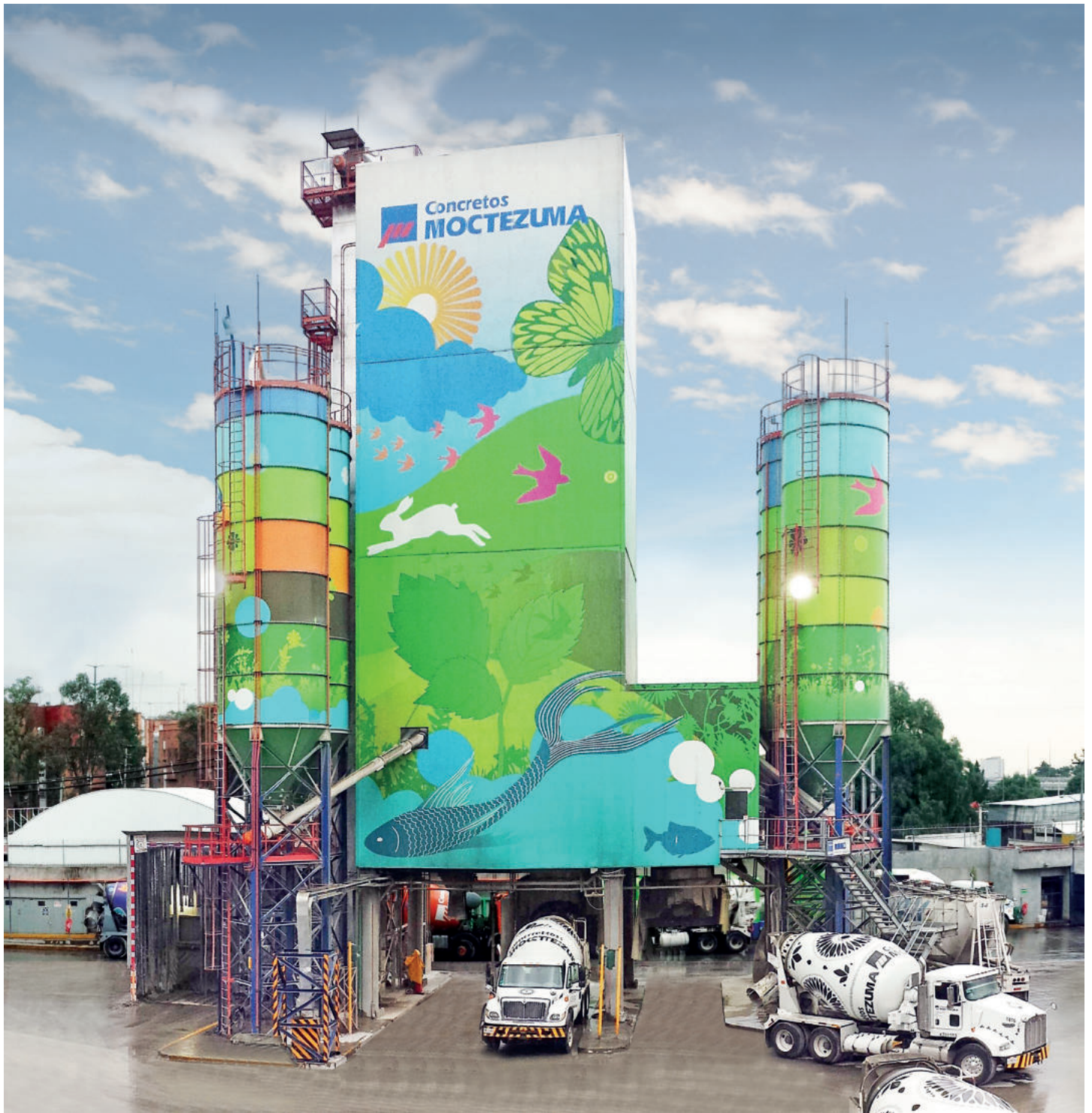
In apertura: un impianto complesso di betonaggio progettato e installato in Messico da MCT Italy.
