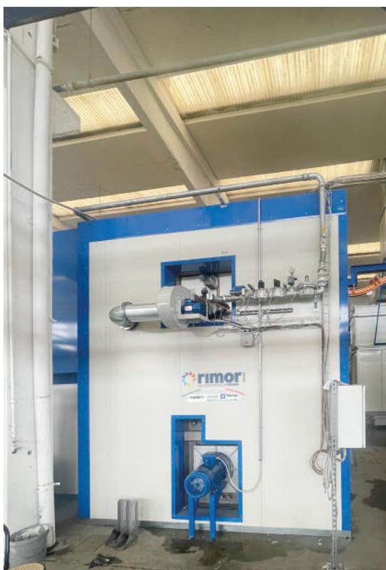
**7 – Il sistema di recupero di calore che, grazie ad un sistema di scambiatori, consente il trasferimento del calore sia al forno di asciugatura del pretrattamento, sia alle vasche di sgrassaggio del pretrattamento stesso.**
